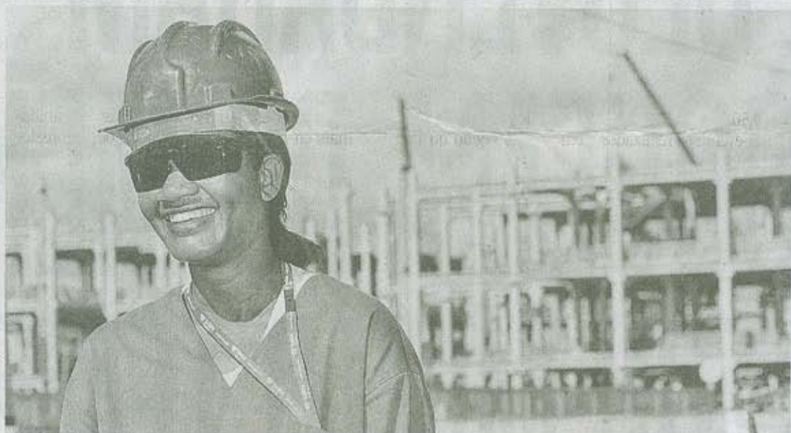
RIOMAR Ontem, o empresário João Carlos Paes Mendonça e o prefeito João da Costa (foto no centro) visitaram o canteiro. Valquíria de Carvalho (acima) foi uma das pessoas da comunidade contratadas para trabalhar nas obras
