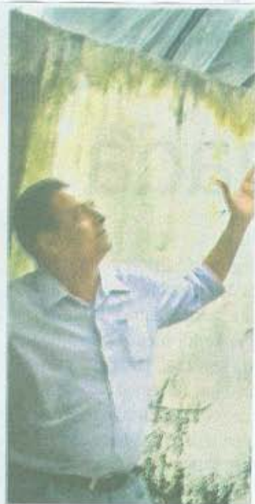
Morador mostra barreira que caiu na Linha do Tiro
