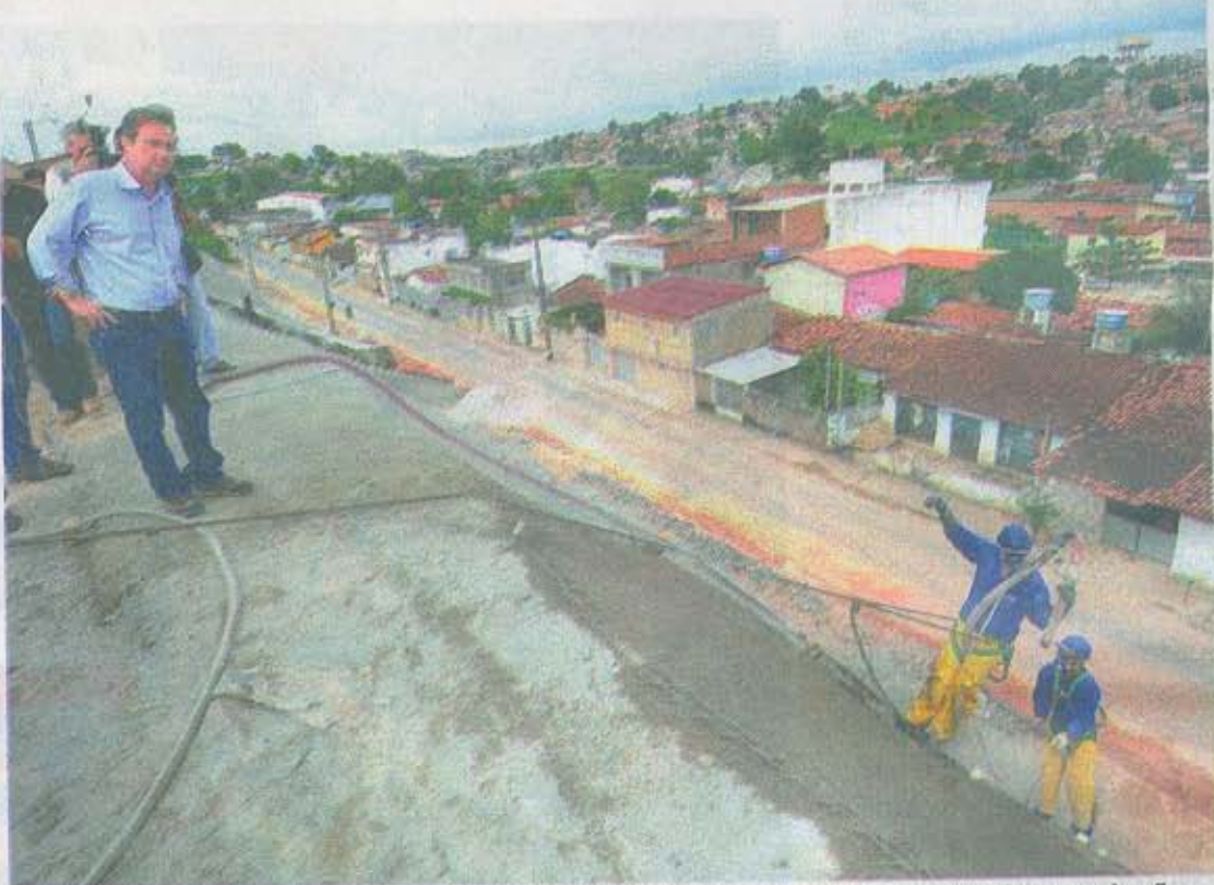
João da Costa fez vistoria em obras de quatro bairros e ouviu críticas da população
