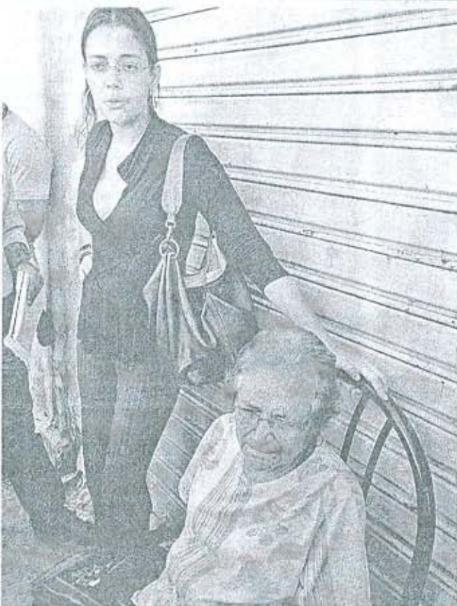
PERIGO O imóvel de n° 187, onde ocorreu o desabamento, está com as paredes rachadas. Moradora da casa vizinha, Maria Albeci foi obrigada a abandonar o local às pressas
